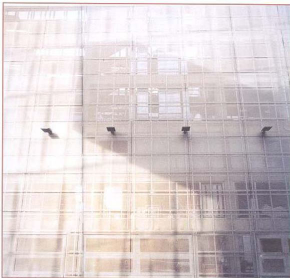
Istočna fasada rezidencije
