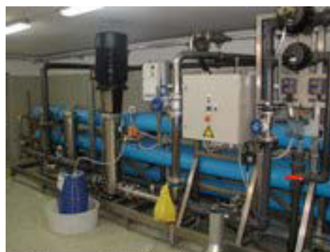
Sistem za deferizaciju i demanganizaciju vode
