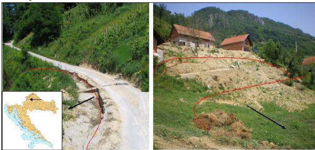
Slika 2: Izgled nekih tipičnih klizišta u bednjanskom kraju: a) najčešći nastanci su kod ceste u zavoju, b) četi su i nastanci klizišta ispod kuća
