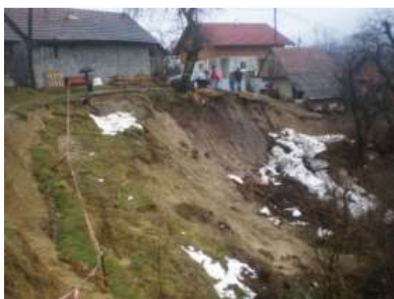
Slika 8: Primjer sanirane padine: a) nakon klizanja – prije sanacije, b) u tijeku sanacije
