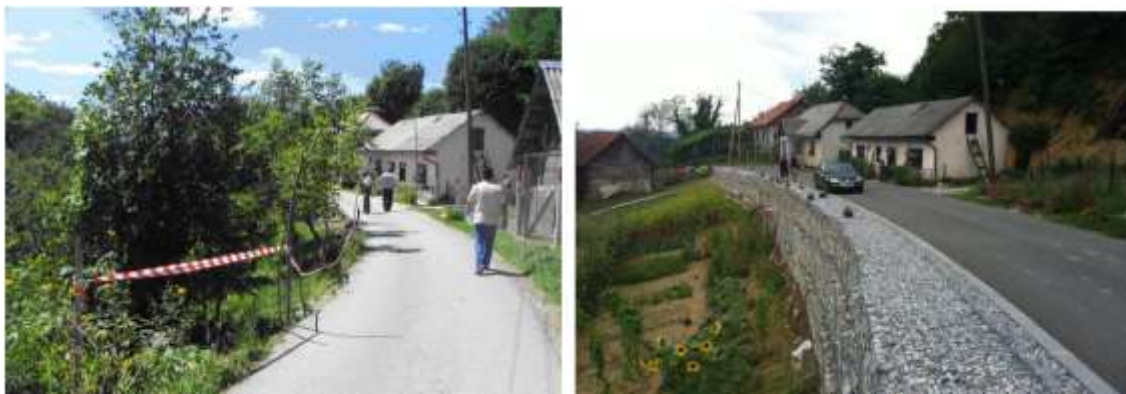
Slika 9: a) prije sanacije; b) sanirano/poslije sanacije
